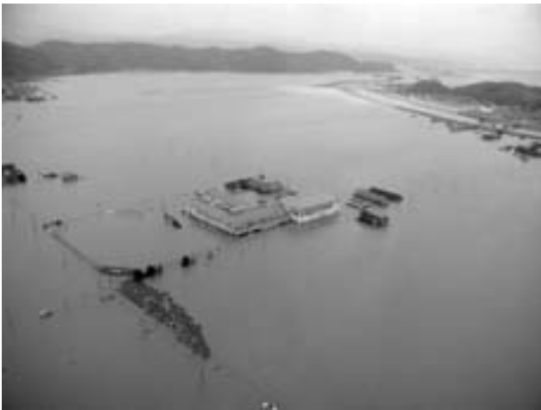
台風第23号による水害で学校が孤立した 出石町立小坂小学校（当時）
